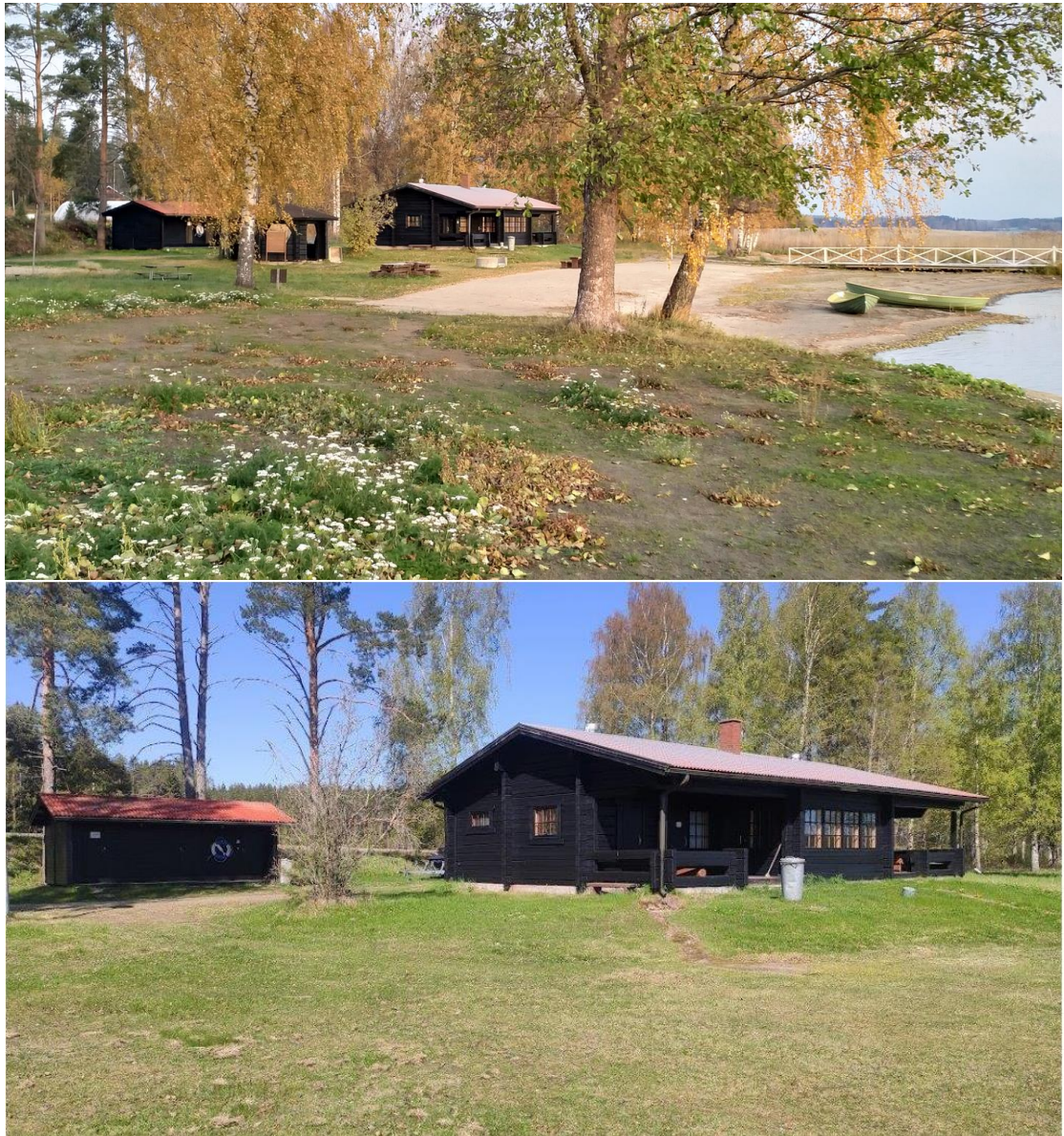
Kuvat 7.1 ja 2: Rantasauna talousrakennuksineen.
